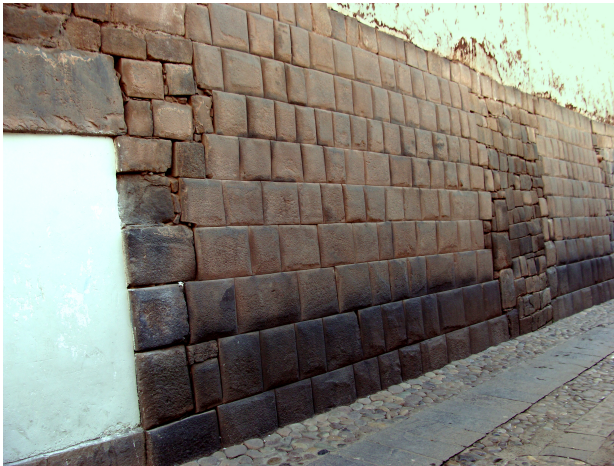
Fig. 1. Cusco, Porzione muraria incaica (ph C. Mazzanti).
