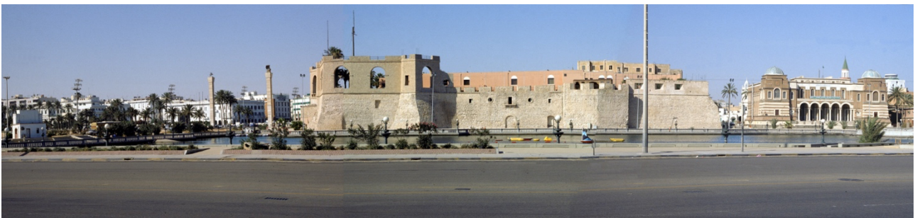
fig. 8. Il waterfront della Medina oggi, dalla strada di circonvallazione tra la Medina e il porto. (Foto L. Micara, E. Vadini)
