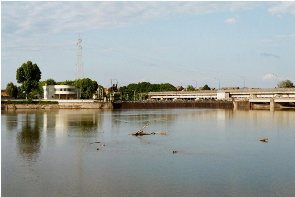
(Fig. 7) Il Po: Ponte-diga e centrale idroelettrica dal parco del Meisino – Foto di Mauro Fontana.
