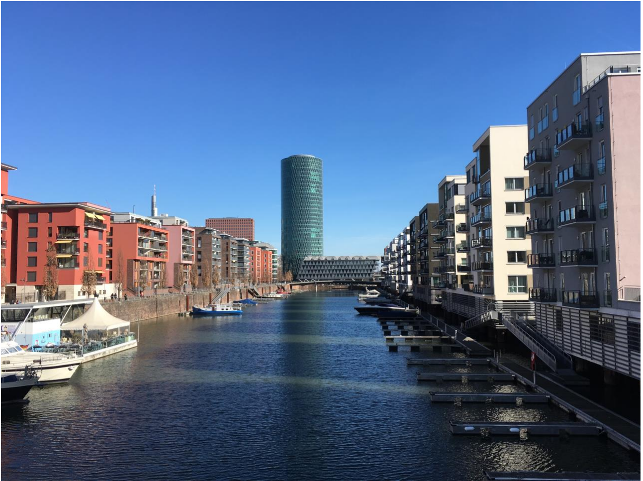
(Fig. 5) Riva destra, intervento sul molo Westhafen . Fonte: R. Mennella.
