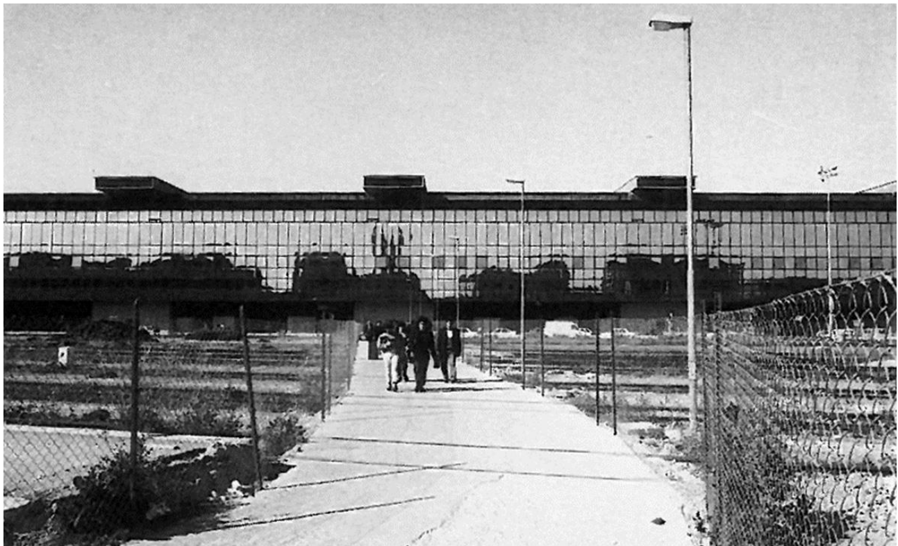
(Fig. 6) - Vista del nuovo impalcato ferroviario
