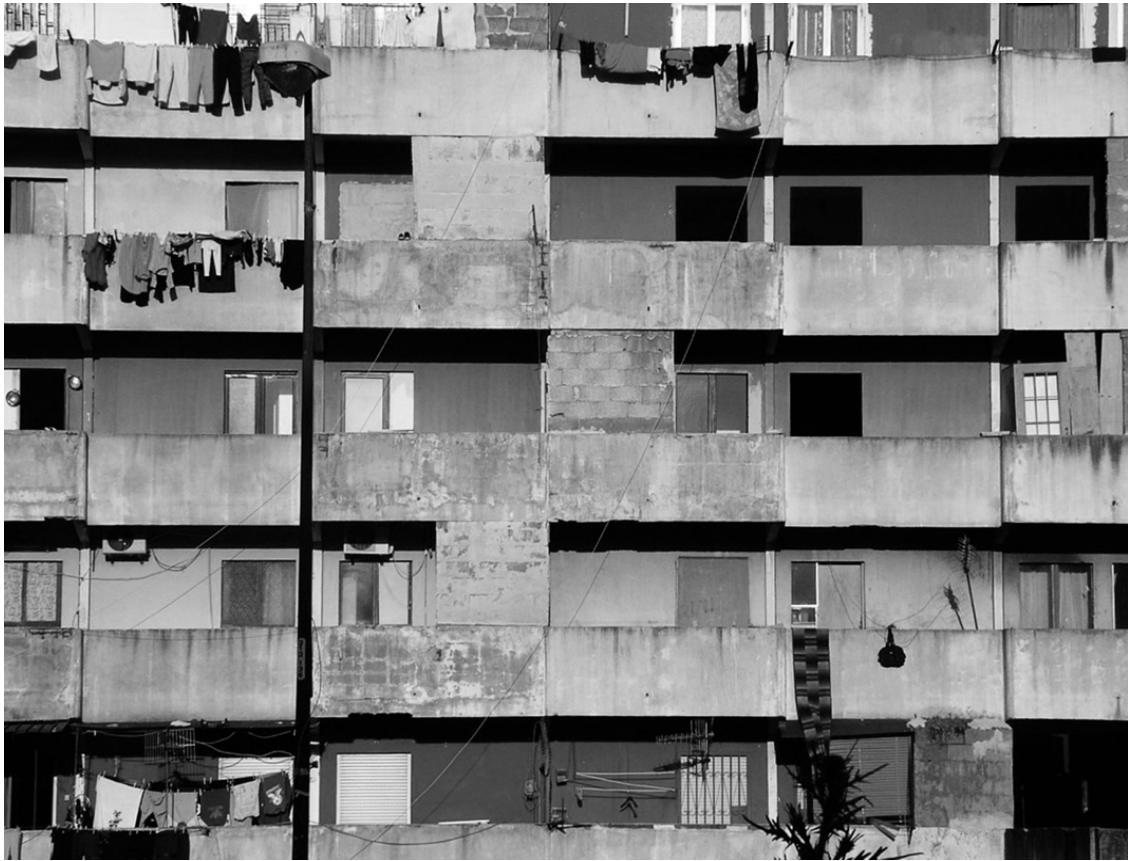
Fig. 7. Particolare della facciata.
