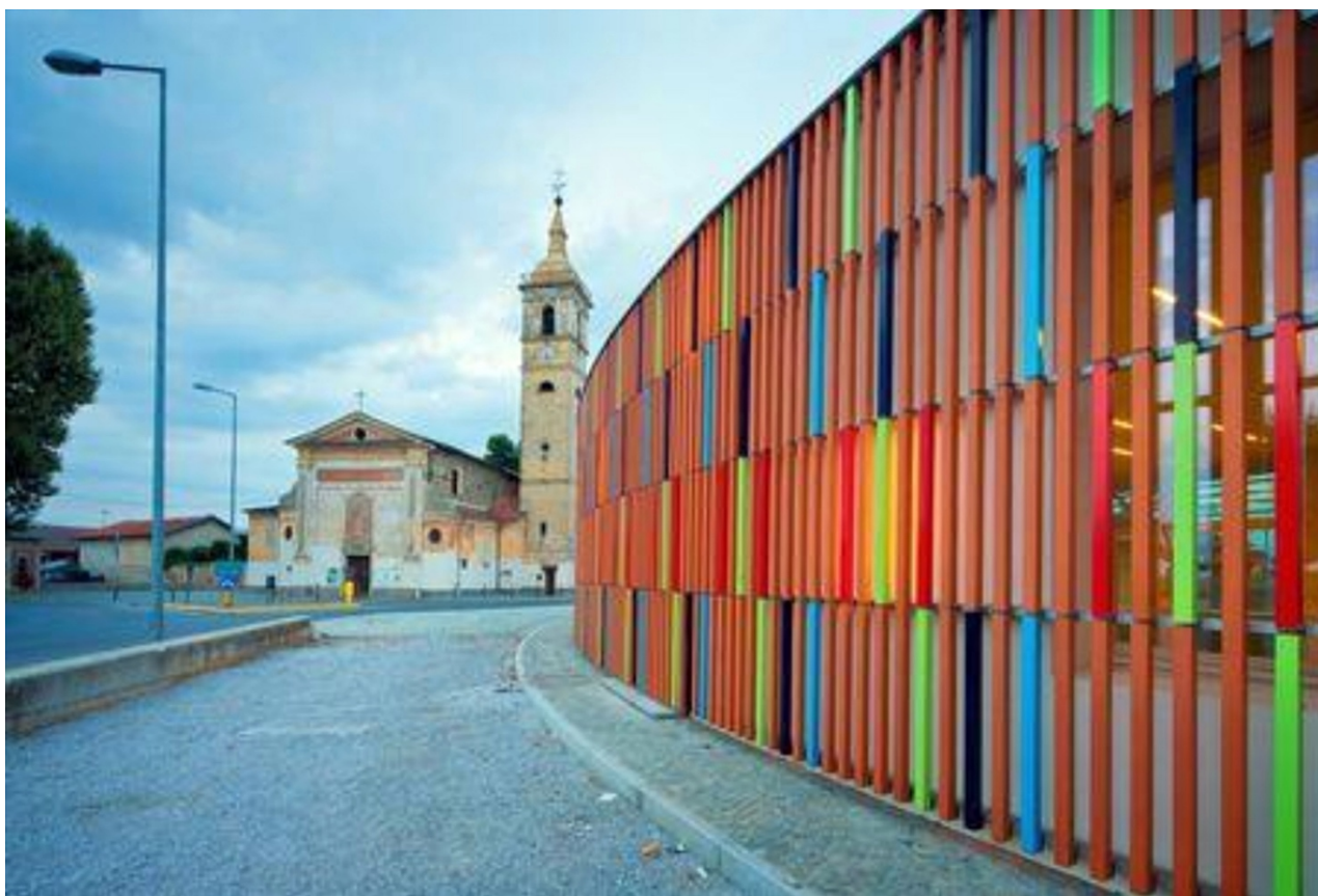
Fig. 8. Ristrutturazione scuola Maltoni a Pontassieve.
