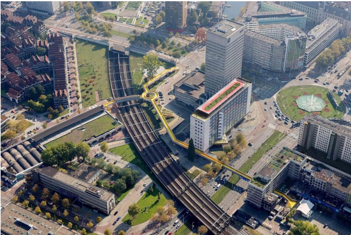
(Fig. 7) Vista dall'alto del percorso pedonale Luchtsingel. Fonte: v8architects.nl
