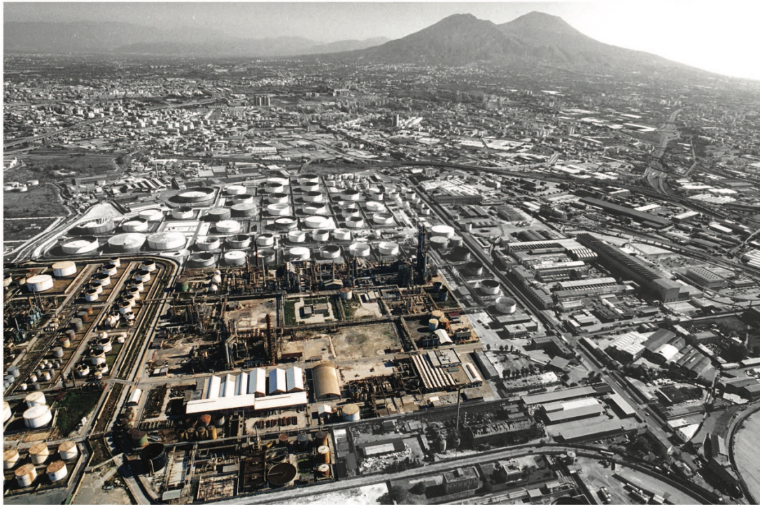
Inquadramento territoriale: vista aerea dello stato dei luoghi precedente le demolizioni
