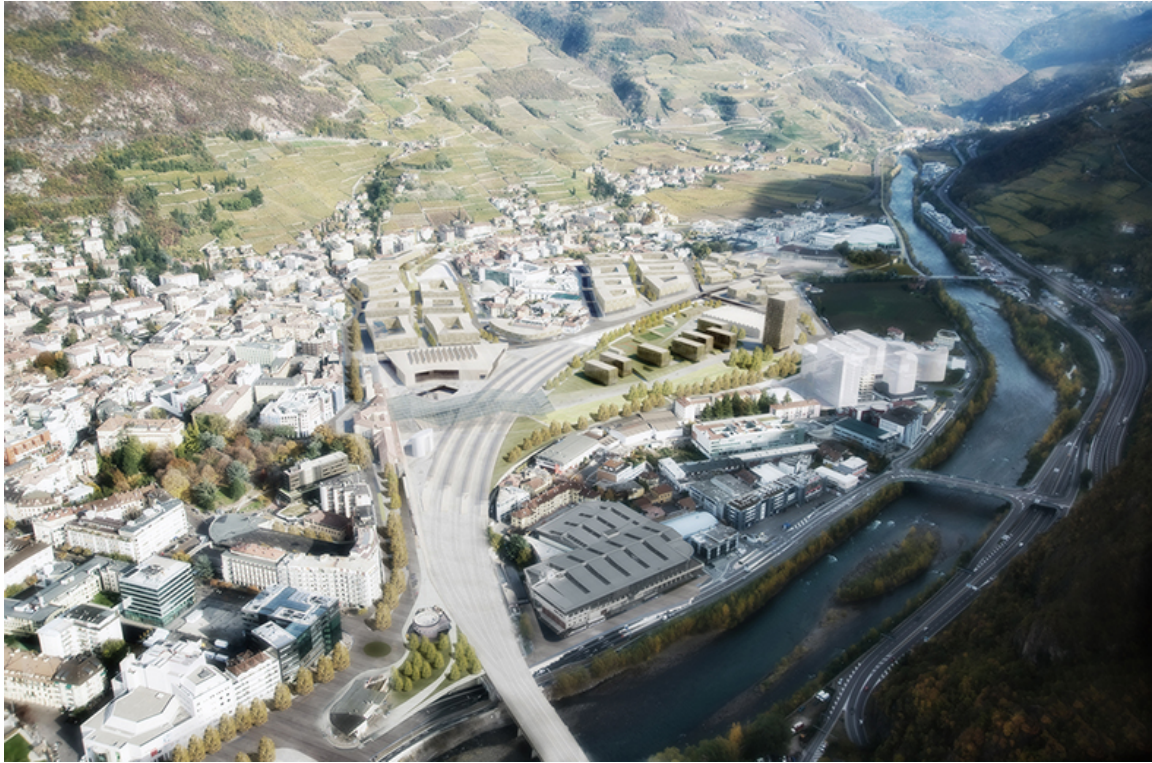
3 - Volo, vista da SUD
