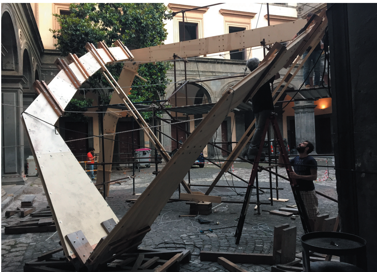
Fig. 8. L’arco e le “costole” della struttura di ReS 4.0, durante la costruzione nel cortile di Palazzo Gravina, Napoli. Fonte: Ph. Sofia Colabella.
