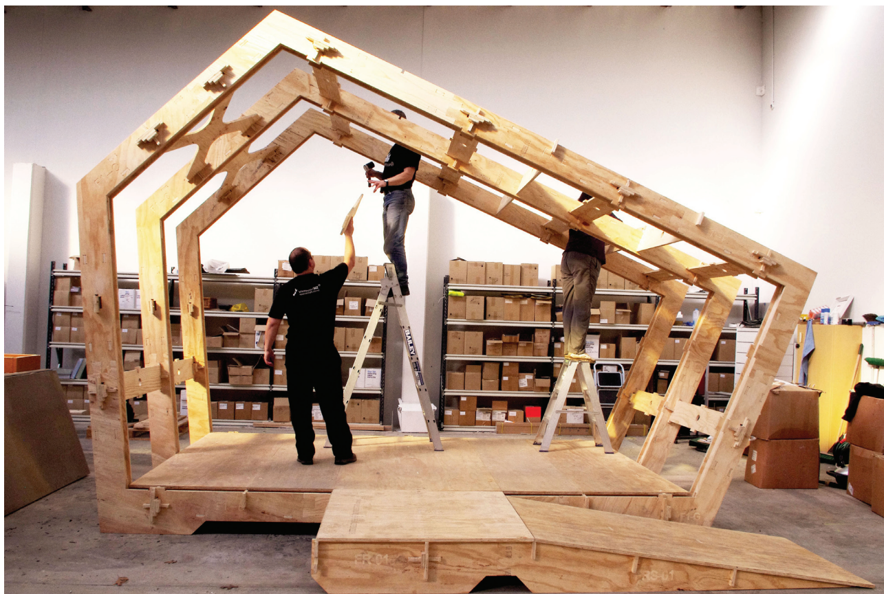
Fig.1. WikiHouse_Costruzione del prototipo. Fonte: http://spacecraft.co.nz/ .
