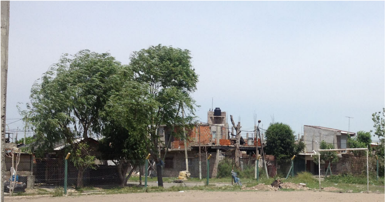
Fig. 4. Alcuni edifici informali della Villa lungo il fiume Requinista. Va considerato che il rischio di inondazione è connesso anche alla problematica dello scarico illegale dei rifiuti, da quelli domestici, a quelli ad alto rischio, ad auto bruciate. Gli abitanti di questi luoghi hanno una relazione particolare con i rifiuti, poiché se da un lato sono fonte di inquinamento e malattie, dall'altro costituiscono risorsa per soddisfare necessità di sopravvivenza.
